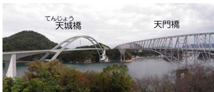
松島方から 1 号橋を見る
